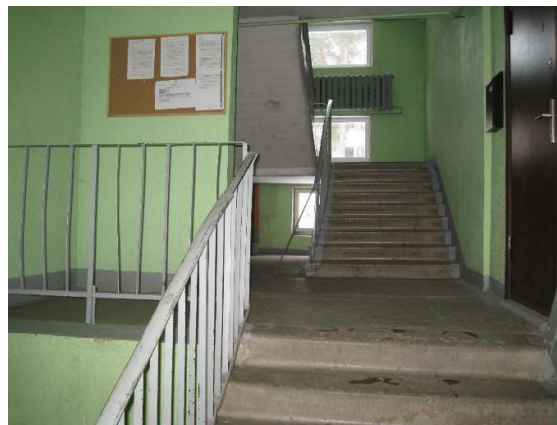
Kāpņu telpa 1.stāvā
