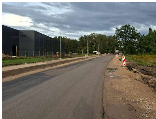
Autoceļa C-19 (Ainavas–Vecinkas) posma no V16 līdz Dzirnieku ielai pārbūve.
