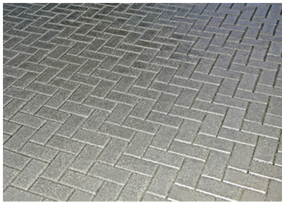
5.attēls. Brauktuves ieklāšanas bruģa raksta piemērs
