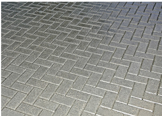
5.attēls. Brauktuves ieklāšanas bruģa raksta piemērs
