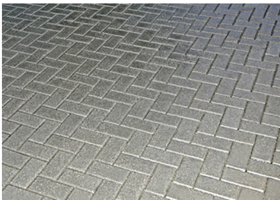
5.attēls. Brauktuves ieklāšanas bruģa raksta piemērs
