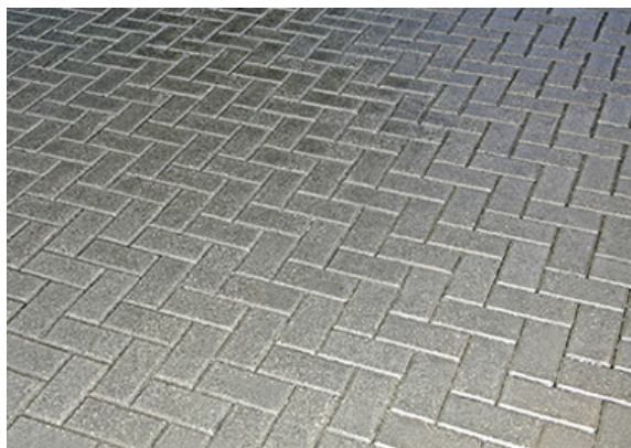
5.attēls. Brauktuves ieklāšanas bruģa raksta piemērs
