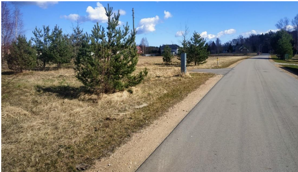
2. attēls. Pašvaldības ceļš "Vārpu ceļš C12" pie detālpļānojuma teritorijas
