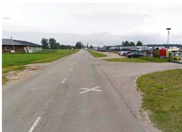
8. attēls. Pašvaldības ceļš C-30 skata virzienā no Detālplānojuma teritorijas uz autoceļu P132
