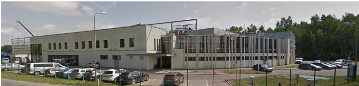
Attēls Nr.5 SIA "S.B.C." teritorija skatā no Zeltiņu ielas-autoceļa V-15 (Stīpnieku ceļš) krustojuma
