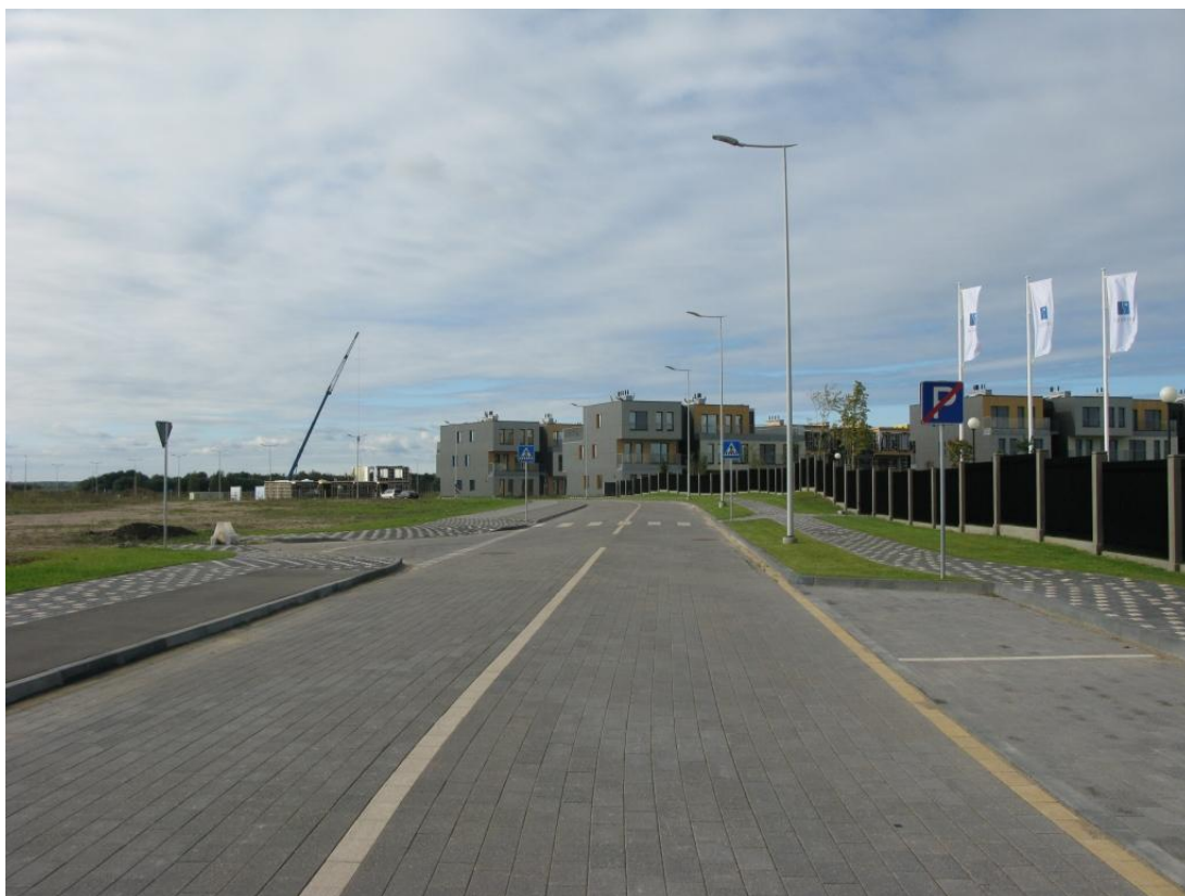
2.attēls. Izbūvētā Salienas iela, parka žogs un realizētais apbūves kvartāls detālplānojuma teritorijā.
