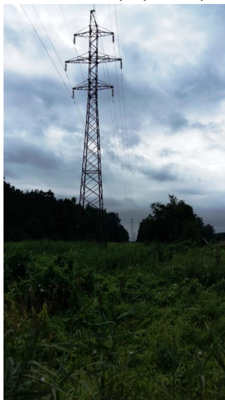
Teritoriju šķērsojoša augstsprieguma elektrolīnija
