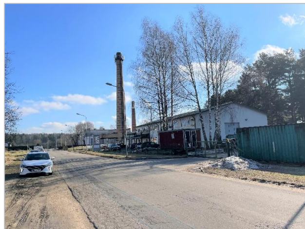
25. attēls. Skats uz apbūvi Priedaines ielas pretējā pusē no lokālpārplānojuma teritorijas.
