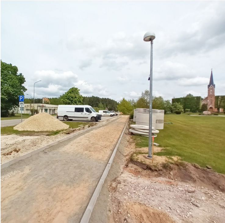
Reģionāla mēroga veloinfrastruktūras izveide Piņķos.
