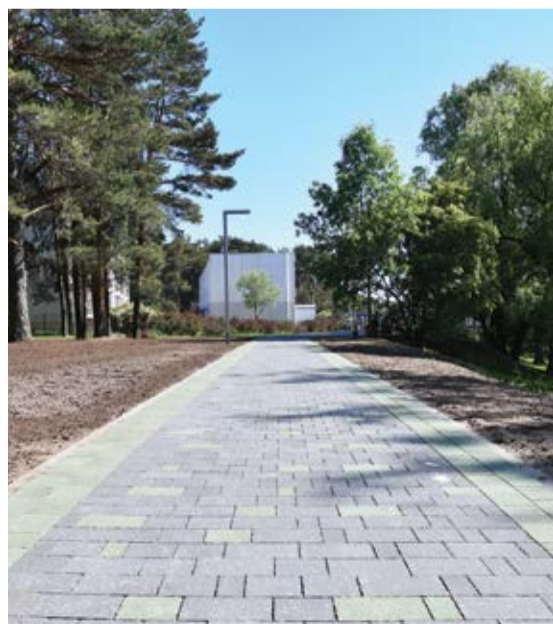
Izbūvēts bruģēts celiņš, kas ved gar jauizbūvēto laukumiņu
