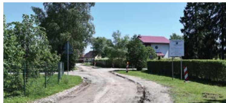
Uzsākti būvdarbi Rožkalnu ielā
