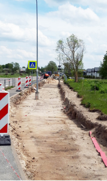
Reģionāla mēroga veloinfrastruktūras izbūve Tīrainē.
