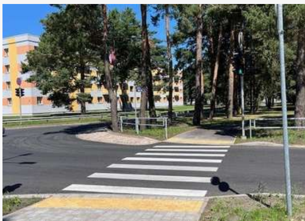
Gājēju pāreja Rīgas ielā Piņķos
