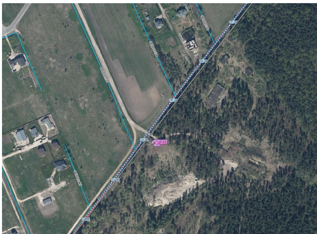
1.att. zemes īpašuma “Mežciems” piekļaušanās ūdens notekai ŪSIK 38122233:27
