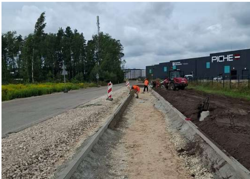
Autoceļa C-19 (Ainavas–Vecinkas) posma no V16 līdz Dzirnieku ielai pārbūve.
