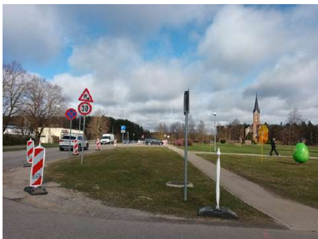
Reģionāla mēroga veloinfrastruktūras izbūve Piņķos.
