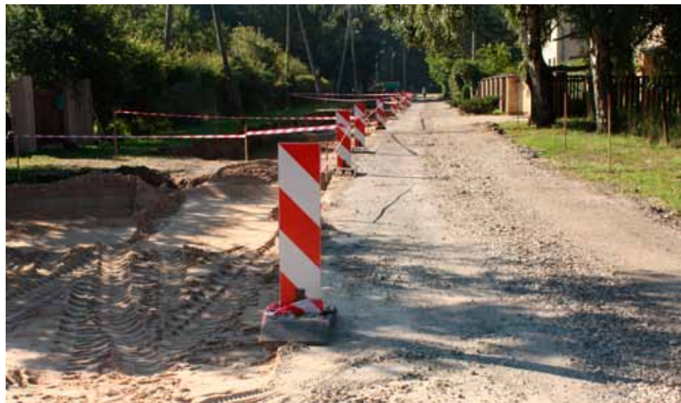
Babītē tiek rekonstruēta Mēness iela, līdz ar to darbojas satiksmes ierobežojumi.
