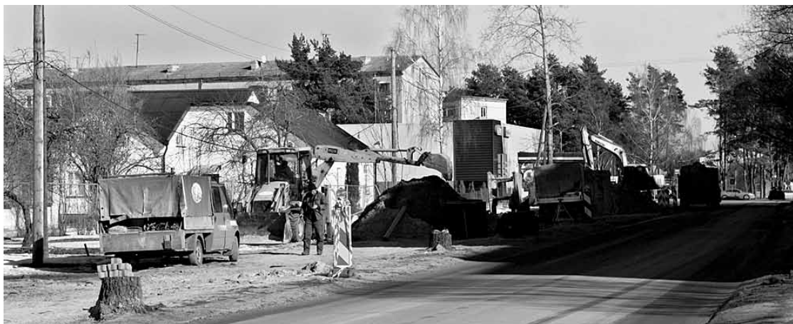
Remontdarbi Rīgas ielā. Zanes Siliņas foto
