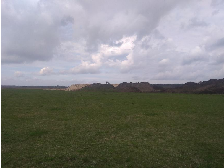
3.attēls Atradne Misiņi 1, valnis gal teritorijas malu būtiski zemāks par tālāk esošajām krautnēm, valnis nenostiprināts un neapzaļumots (foto I.Gavena)
