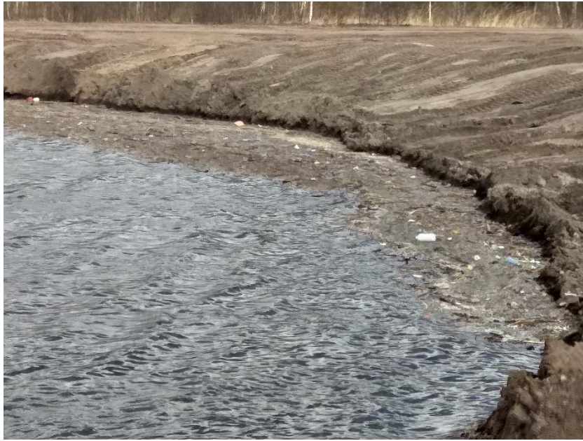
9.attēls Atradne Gundegas, piebērtā ierīkojamā dīķa daļa un piesārņojums ar no iebērtā materiāla izskalotiem atkritumiem (foto I.Gavena).
