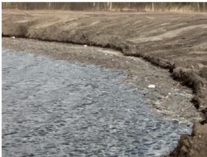
9.attēls Atradne Gundegas, piebērtā ierīkojamā dīķa daļa un piesārņojums ar no iebērtā materiāla izskaloziem atkritumiem (foto I.Gavena).
