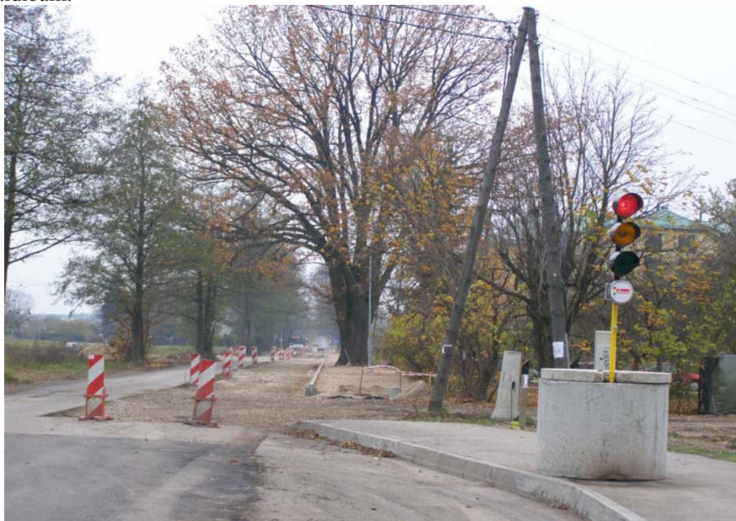
Attēls Nr. 5 Kantora ielas rekonstrukcija, 2008.g.rudens.
