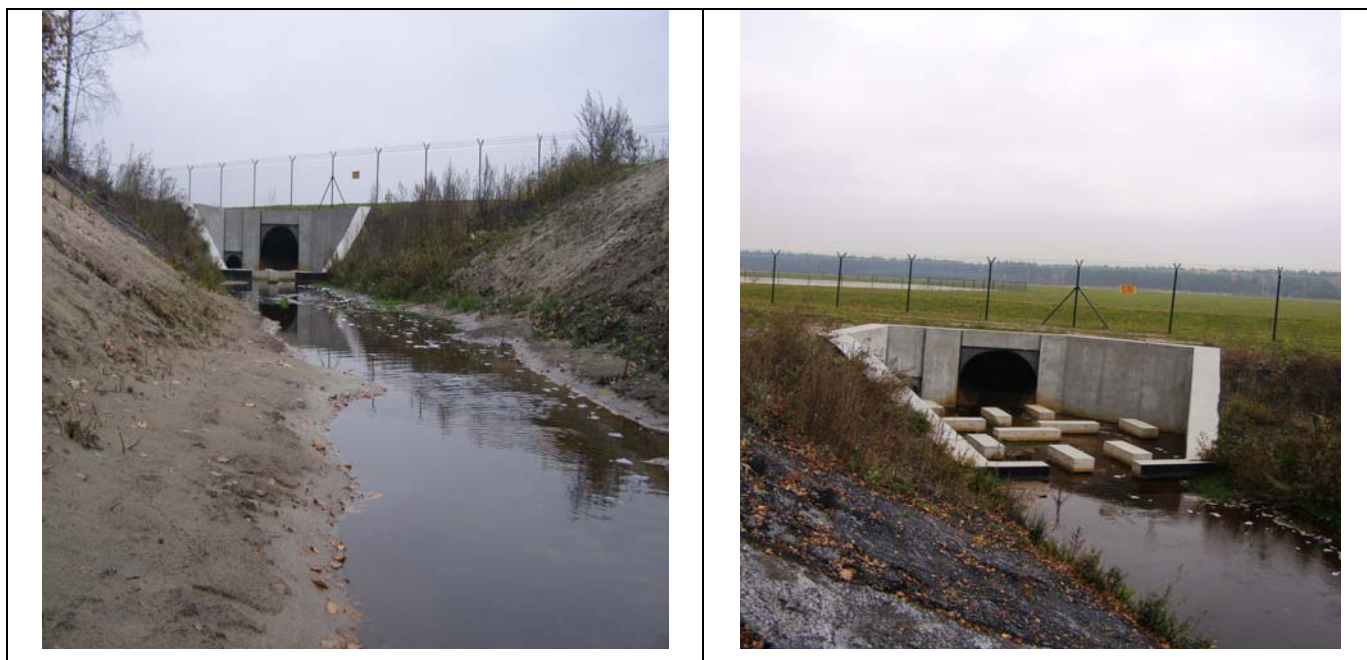
Attēli Nr.10;11;12.Lidostas teritorijas lietusūdeņu savākšanas sistēma, novadgrāvis ieplūst Neriņas upē.
