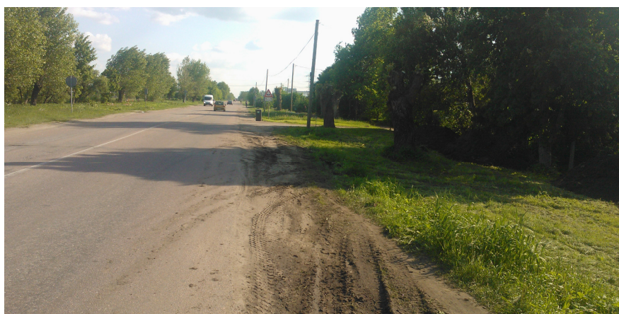
2. att. – Pk 5+30 (2. posms; skats uz trases sākumu) – nomales sajaukšanās ar pamatnes grunti, iesēdumi un rises.
