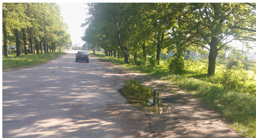
3. att. – Pk 1+68,26 (3. posms; skats uz trases sākumu) – ūdens novades problēmas no autoceļa nomales.
