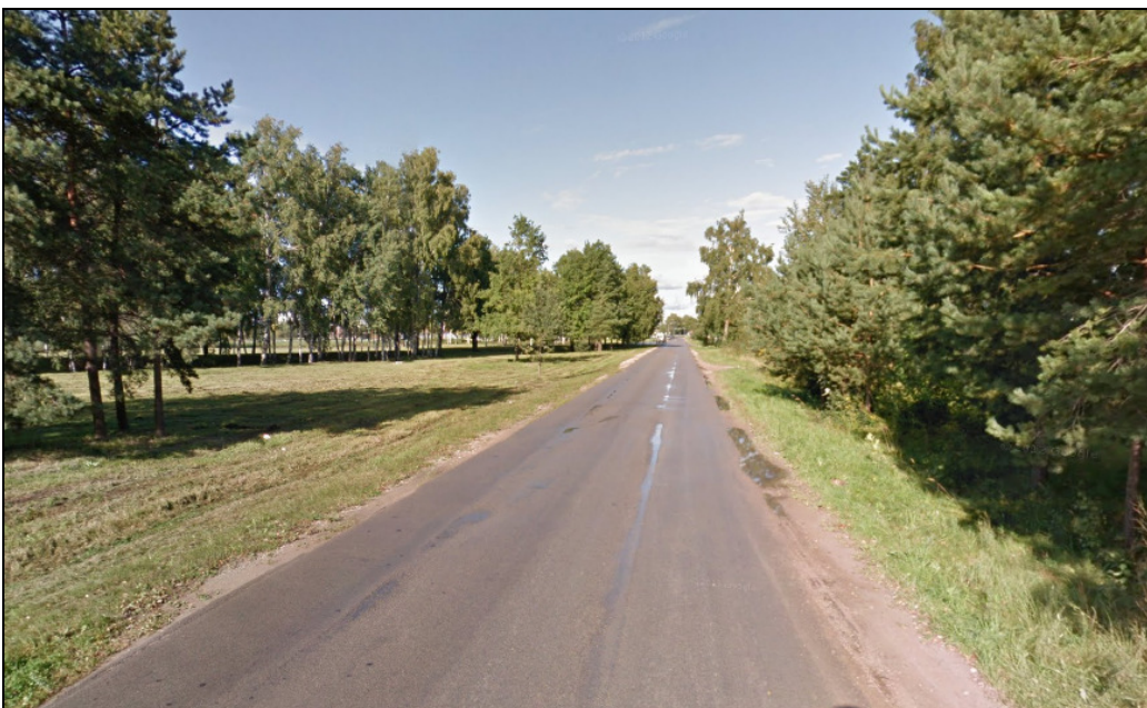
3.attēls. Asfaltbetona segumā izveidojušās rises, kurās lietus laikā uzkrājas ūdens
