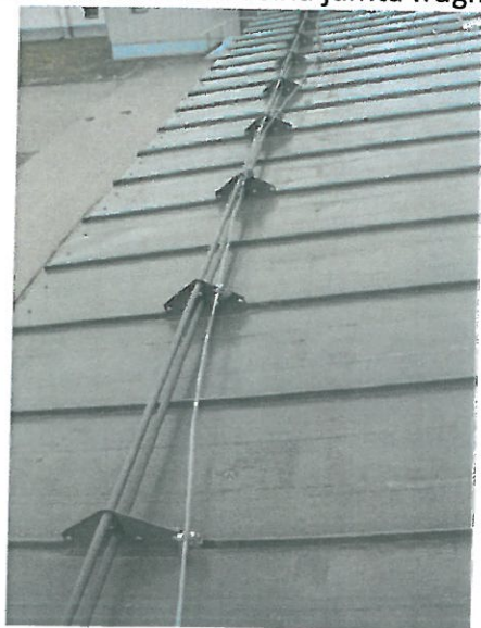
17. attēls. Peldbaseina jumta dzegas posms. Atrauti jumta zemējuma stiprinājumi.
