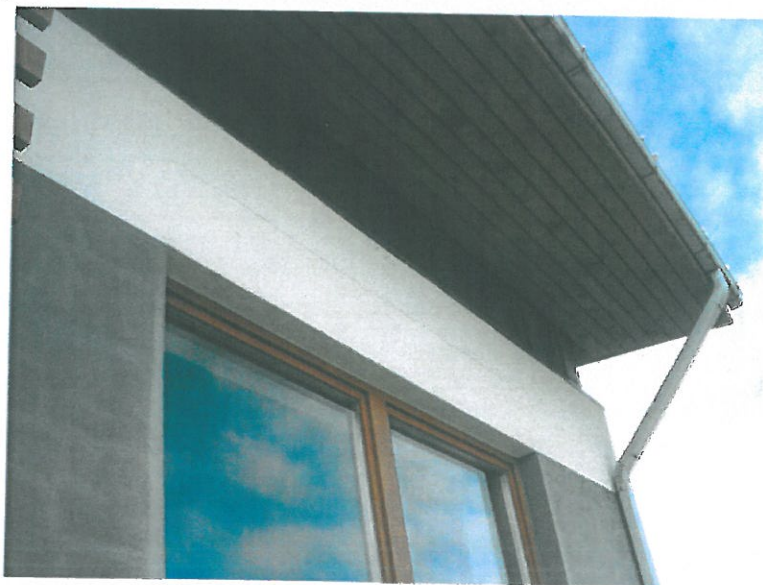
17. attēls. Peldbaseina jumta dzegas posms. Atrauti jumta zemējuma stiprinājumi.
