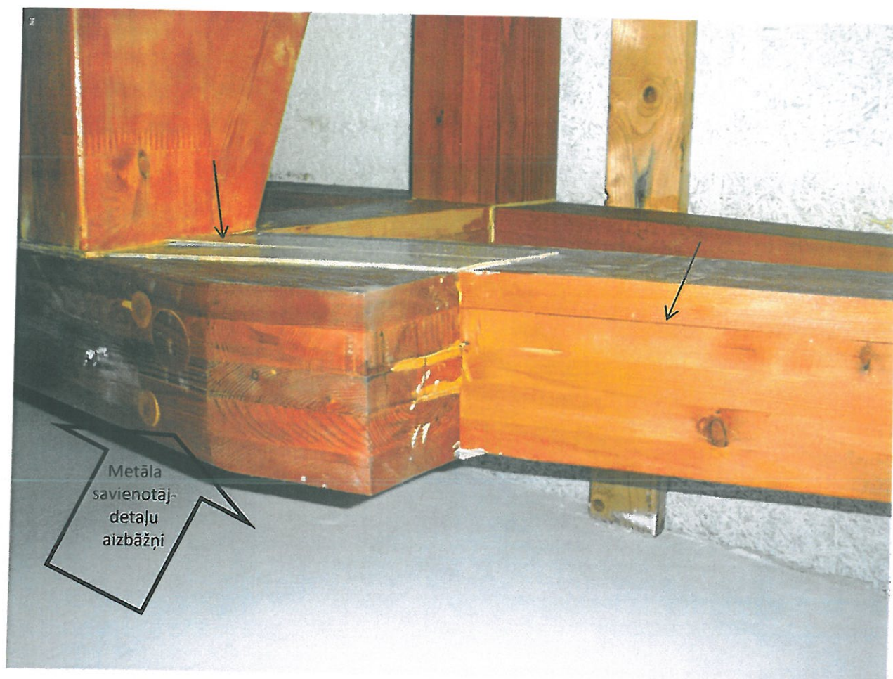
8. attēls. Līmēto elementu atslāņošanās. Redzamas kopņu elementu slēpto metāla savienotājdetaļu aizbāžņu vietas.
