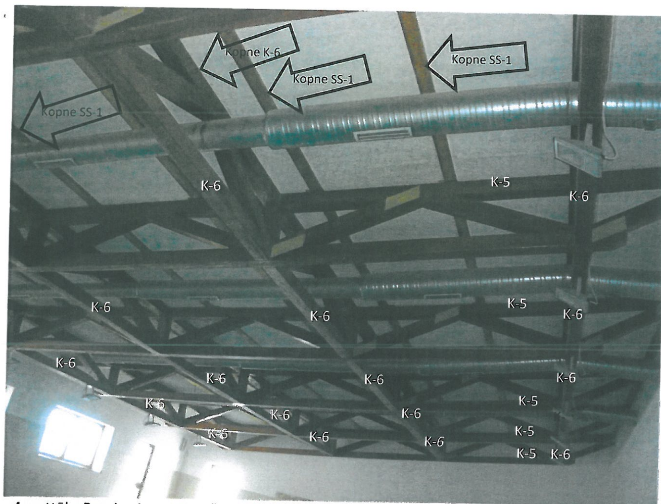
4. attēls. Baseina jumta nesošās konstrukcijas ar projektā pieņemto marķējumu.
