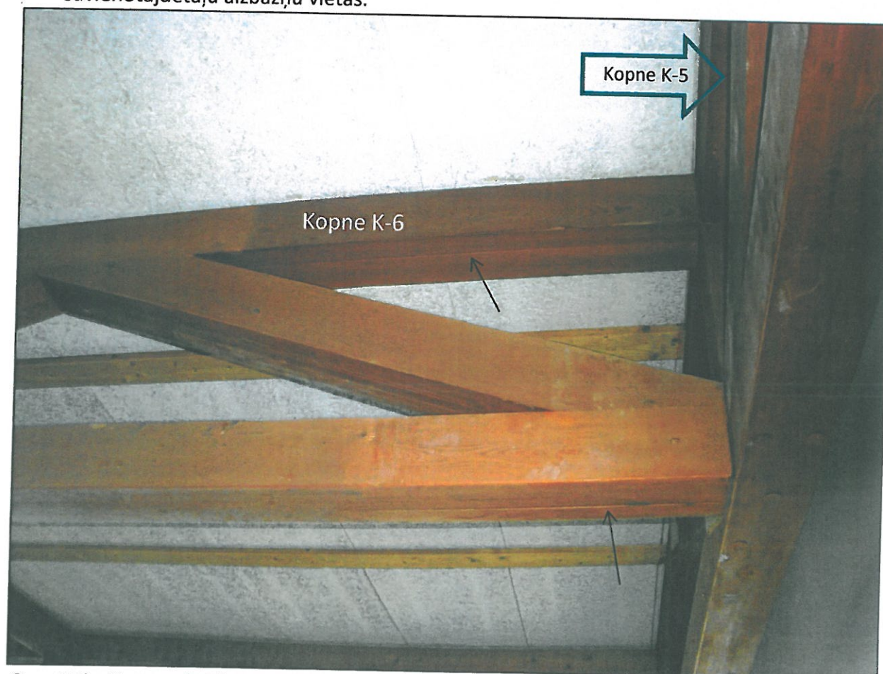
9. attēls. Kopnes K-6 līmēto elementu atslāņošanās. Redzamas kopnes KP-5 elementu slēpto metāla savienotājdetaļu aizbāžņu vietas.
