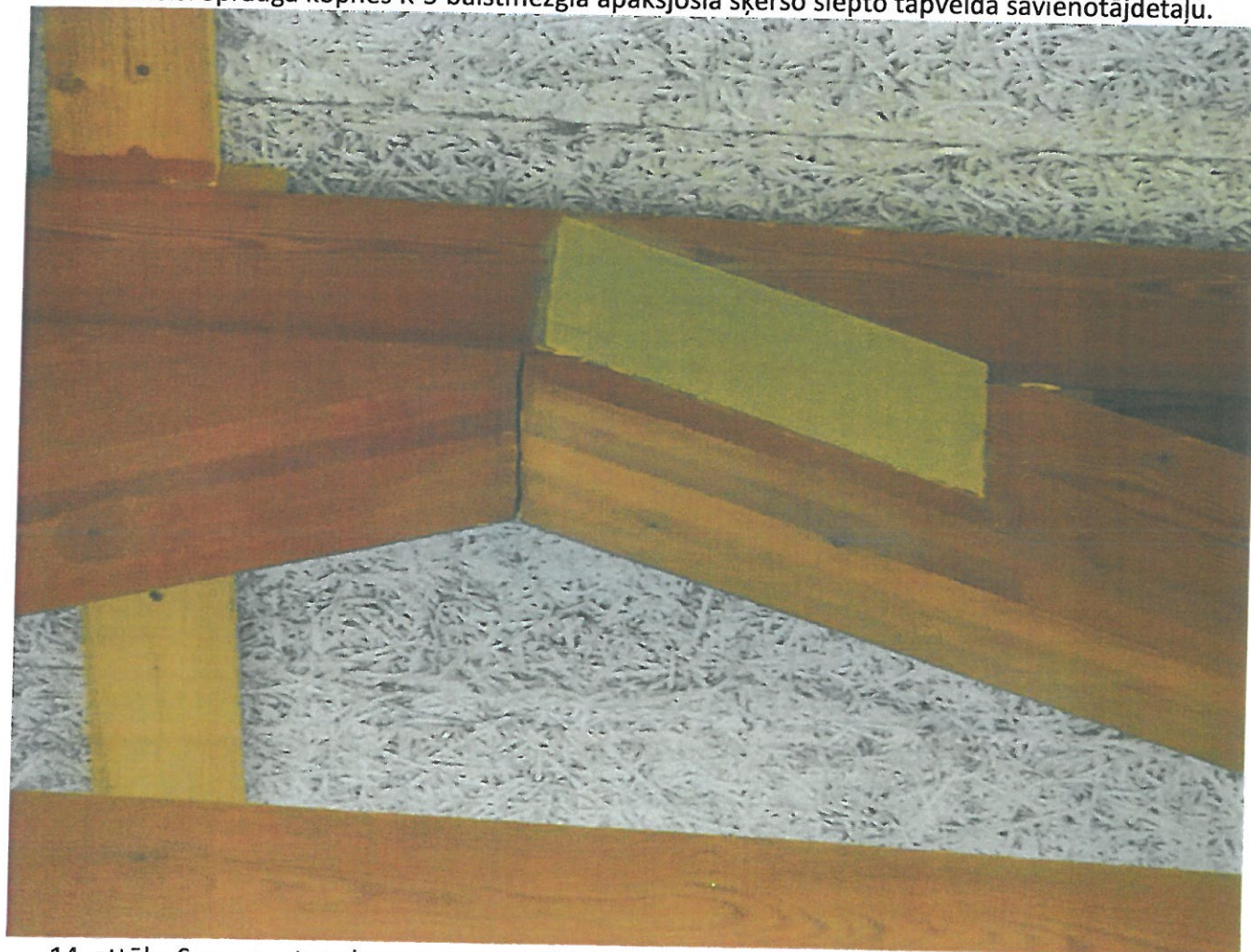
14. attēls. Sprauga starp kopnes K-5 atgāžņiem.
