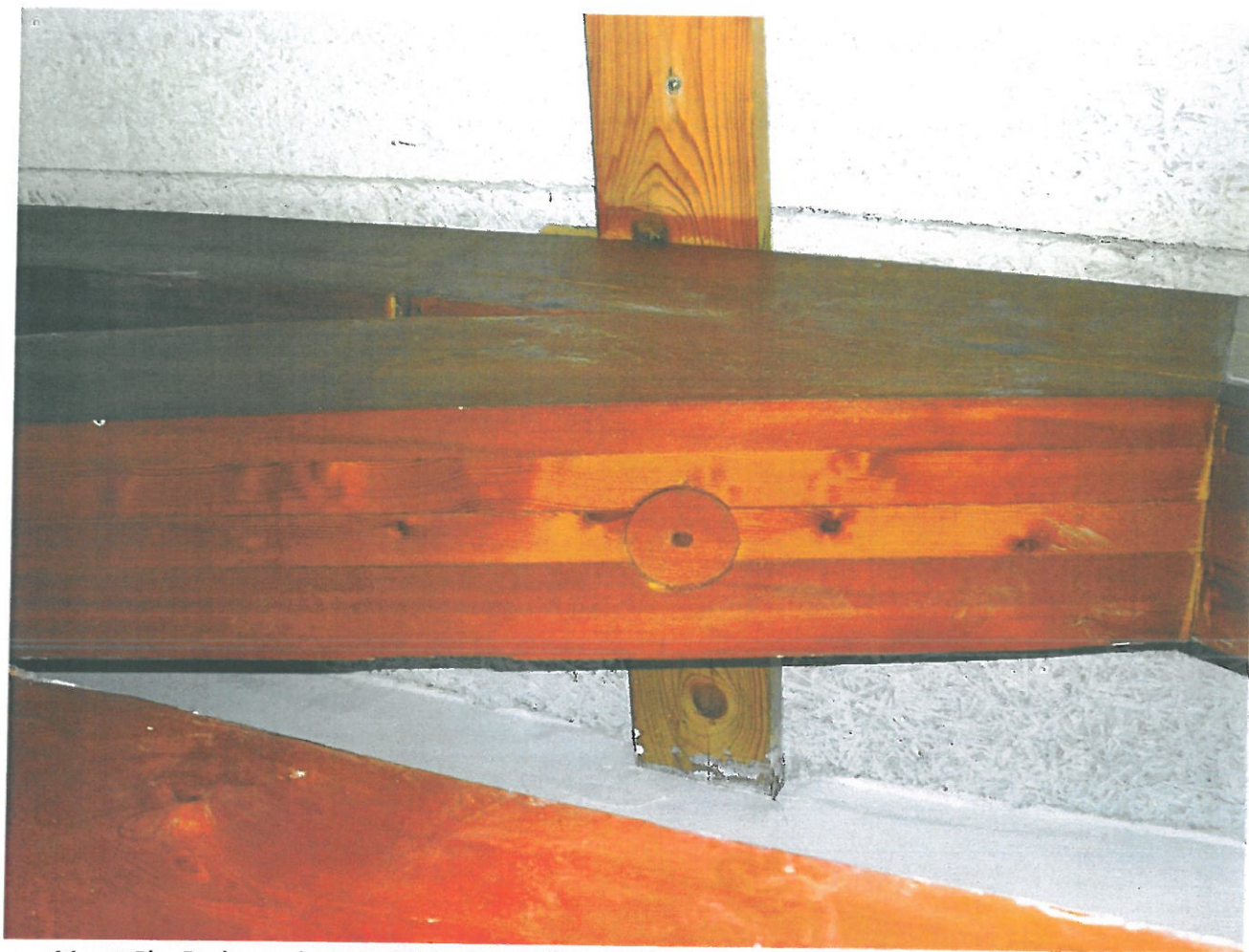
11. attēls. Redzams kopnes K-5 spiestā elementa pievienojuma mezgls augšjoslai.
