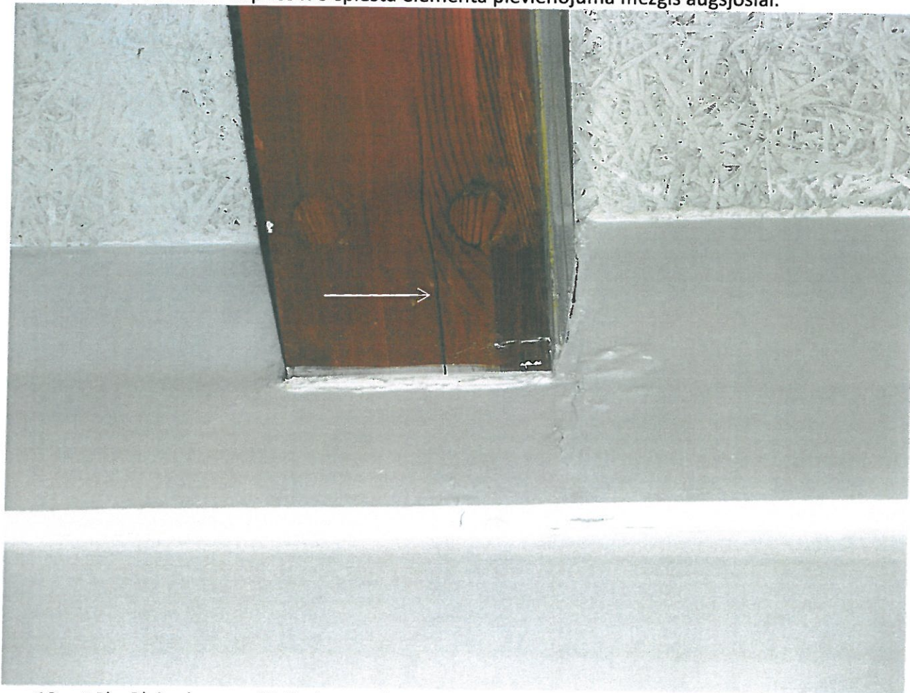
12. attēls. Plaisa kopnes K-5 balstmezglā apakšjoslā.
