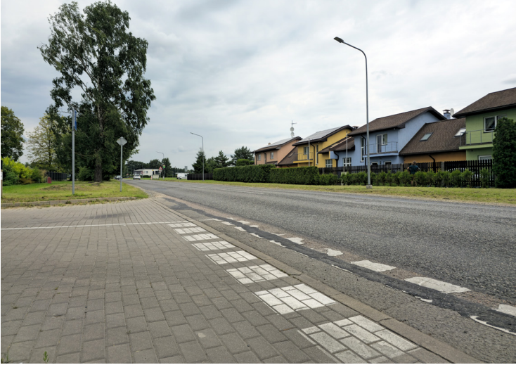
Lielās ielas posms Mārupē pirms darbu uzsākšanas (2026. gada augusts).
