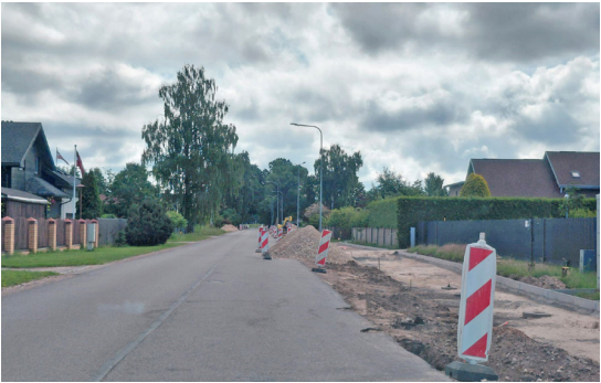
Ietves izbūves darbi Ventas ielas posmā no Kurmales ielas līdz Dzelzceļa ielai Mārupē.
