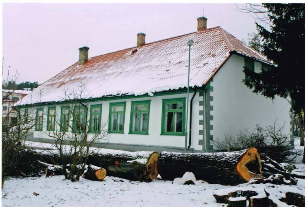
3.fotoattēls. Ēkas kopskats skatā no austrumiem.
