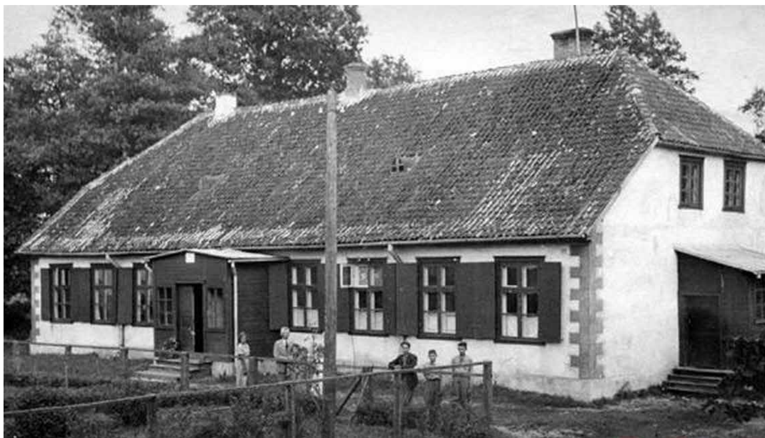
2. attēls Mazcenas pamatskola Ziemeļu fasāde
