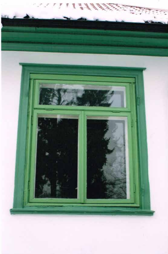
14.fotoattēls. Domājams, 20.gs.40.gadu loga aploda (sekundāri apšūta ar dēļiņiem), seglīstes un slēģu viru kāši.
