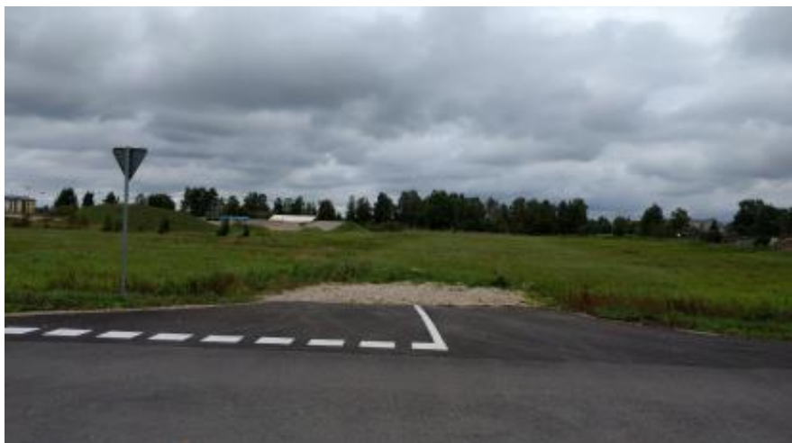
Izbūvētā iebrauktuve no Lapiņu dambja detālplānojuma "Laukkalniņi" teritorijā
