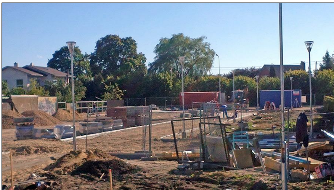
25.attēls. "Sporta laukums Gerberu ielā, būvniecība 2015.gada septembrī"
