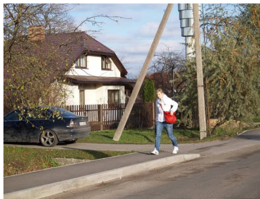
Izbūvētas gājēju ietves Vecozolu ielā 1518 m un Rožu ielā no Mārupītes gatves līdz Lielai ielai 646 m garumā,
