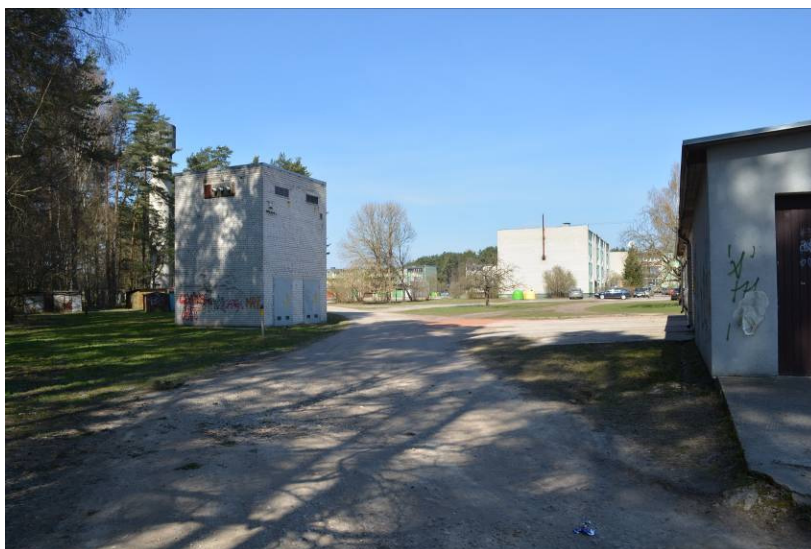
3. att. – piebraucamajam ceļam nav konstanta garenprofila un šķērsprofila. Nav nodrošināta lietus ūdens atvade.
