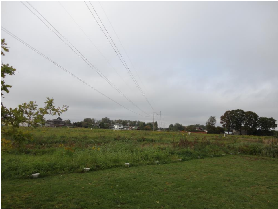
14.attēls. Skats uz 330kV augstsprieguma elektropārvades līniju, kas šķērso detālplānojuma teritoriju
