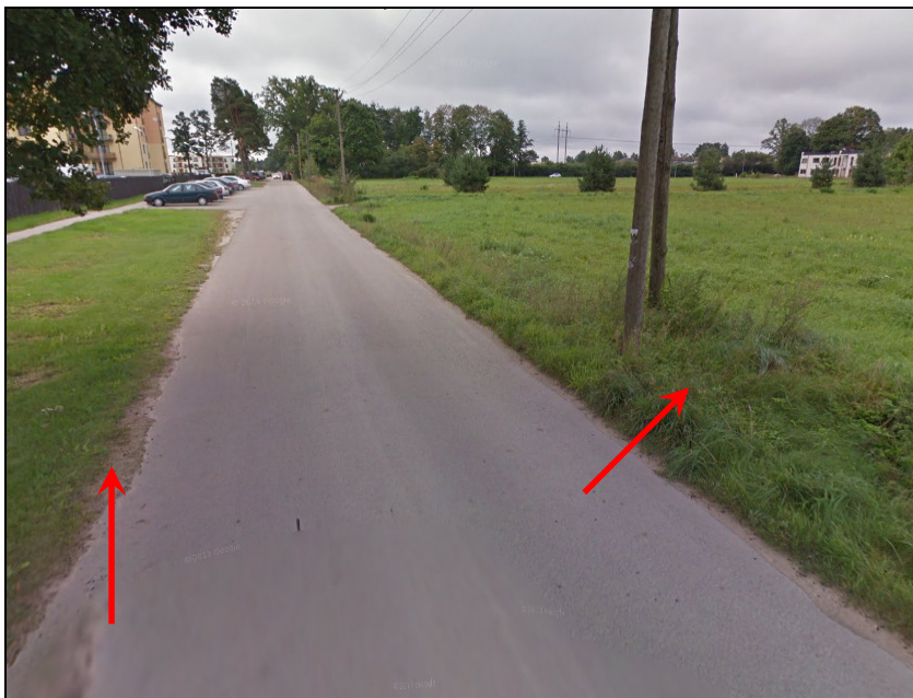
5. att. – rekonstruētais ielas posms, kuram novērojams nomaļu apaugums un nav izbūvēti sāngrāvji
