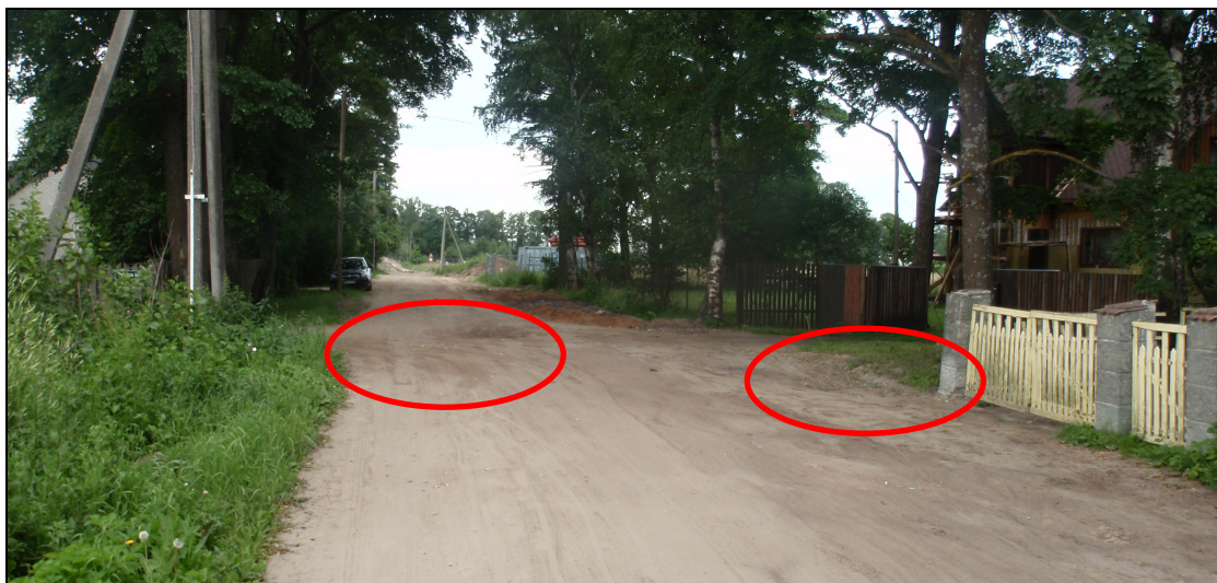
3. att. – atsevišķu ielas posmu segumā ir izveidojušās bedres un konstatēti iesēdumi
