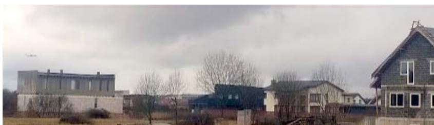
Foto 2. ZR no detālplānojuma teritorijas esošā savrupmāju apbūve
