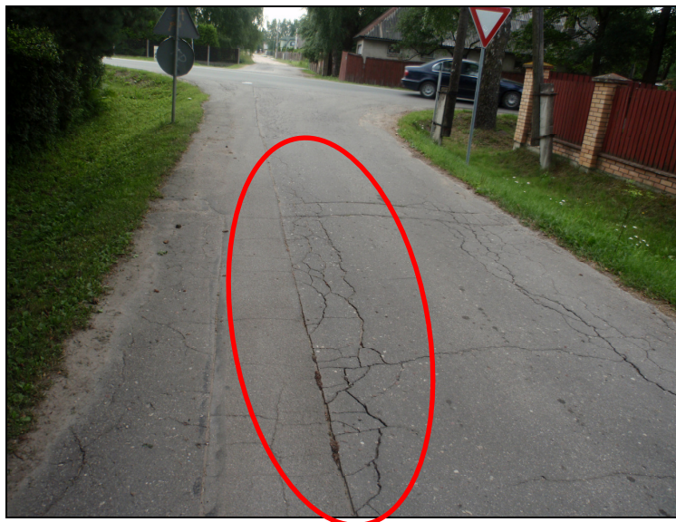
4. att. – asfalta segumā vērojams sazarots plaisu tīkls
