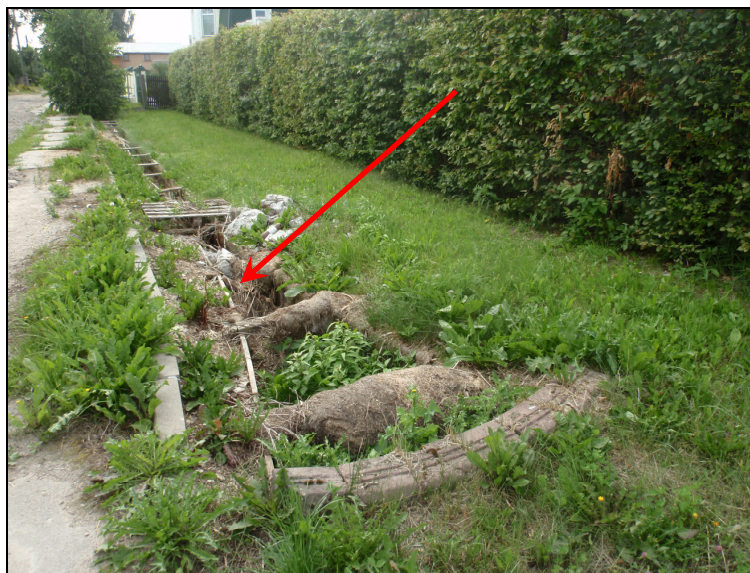
5.att. – sāngrāvis aizsērējis kavējot ūdens atvadi
